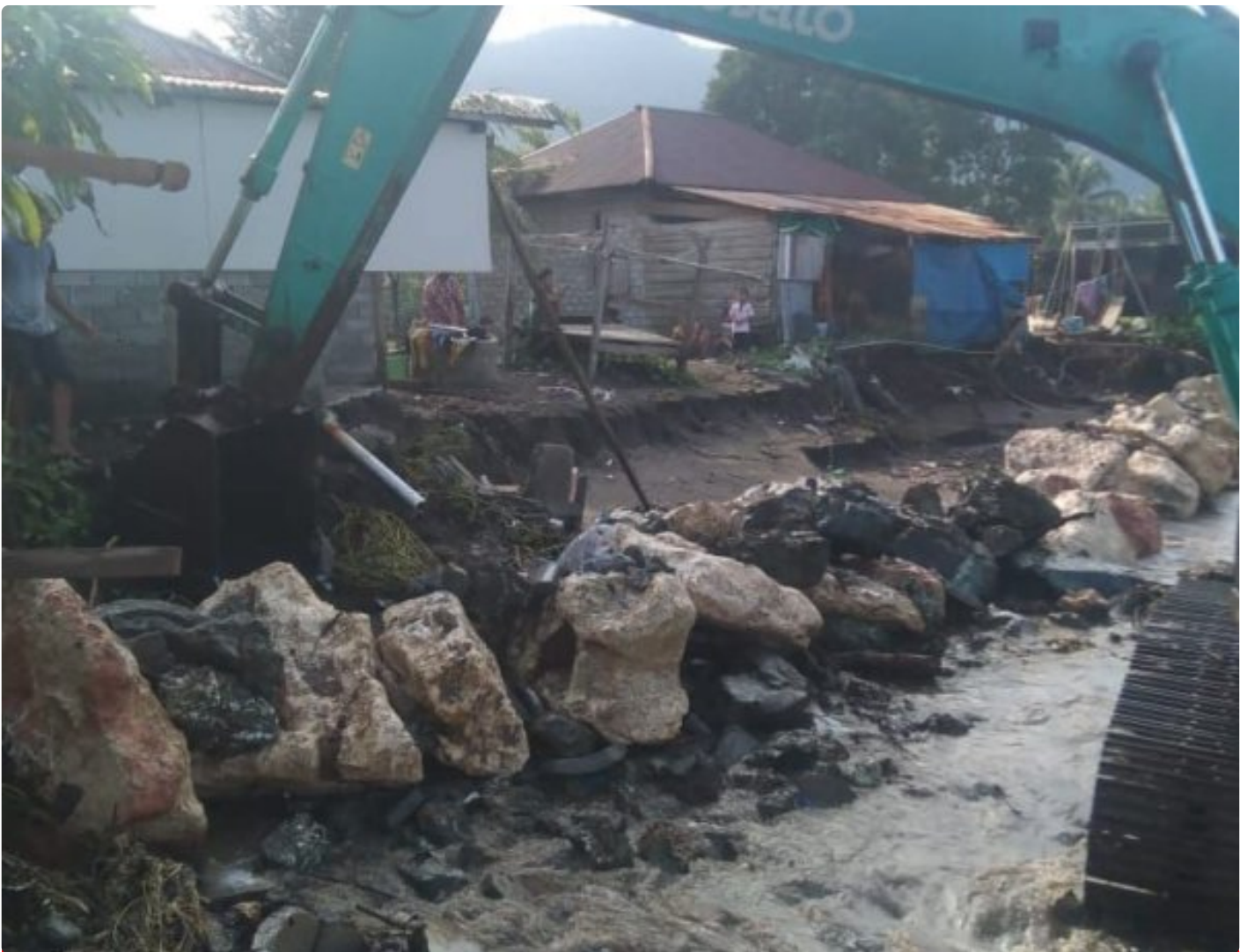
Proyek pemecah ombak di desa kolono
